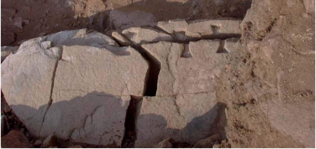
Şekil 18. Güney Kulesinin kuzey duvarındaki yarılmış granit kesme taş bloğun onarımı için yapılmış küçük kenet delikleri sırası. Bitimi soldaki toprağın içinde kalan bu blok olasılıkla köşe taşıdır. (04dpjv2219)
