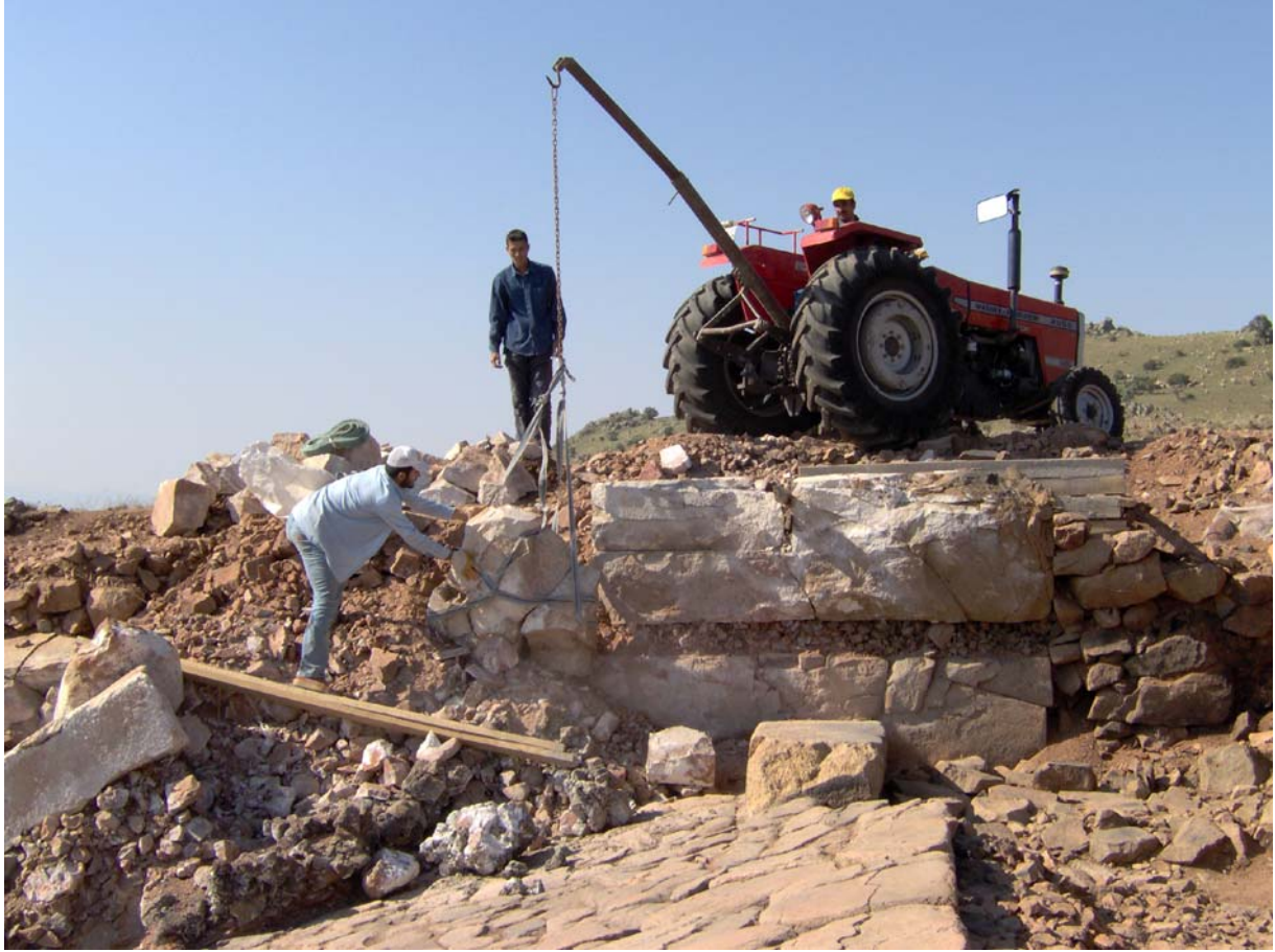
Şekil 24. Taşların arasındaki yatay kirişin yanması ile oluşan boşluk Güney Kulesi'ne ait duvarın yapısal açıdan dengesini yitirmesine neden olmuştur. Cephe kaplamasını oluşturan taş bloklar ve yanmış moloz, doğal olarak beyaz karbonatlarla kaplı halde bulunmuştur. Yangının şiddeti ile parçalanan çok büyük bir blok güvenlik sebebi ile kaldırılmıştır. (05dphp1104)
